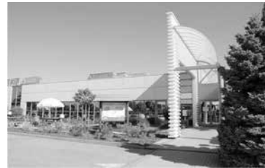
Entrée bâtiment A
