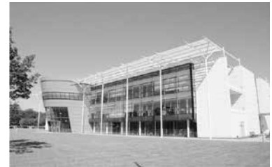
Entrée bâtiment E
